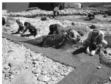
植生マットの敷設作業中
