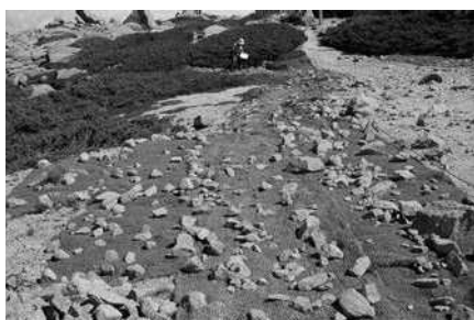
植生マットの敷設完了
