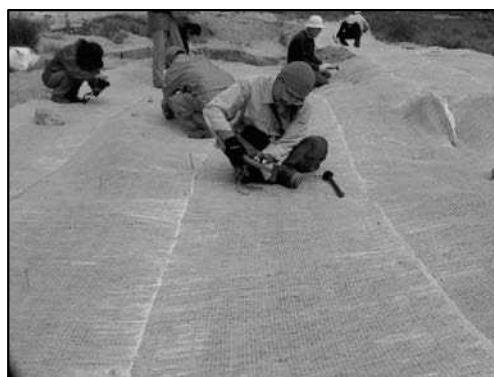
写真-9 生分解性マット張り作業
