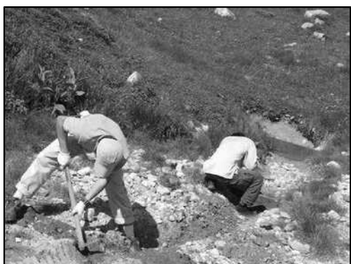
写真-8 素掘りによる水路作設
