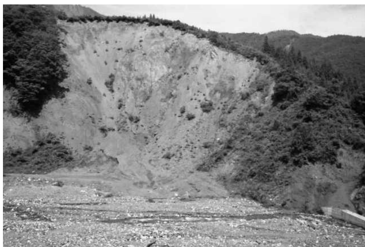
写真-1 能郷谷門原崩壊地
