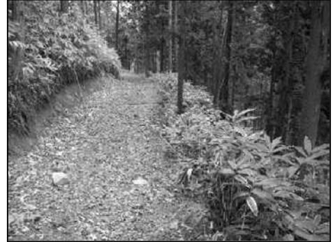
(写真-5) 安定した法面の様子
