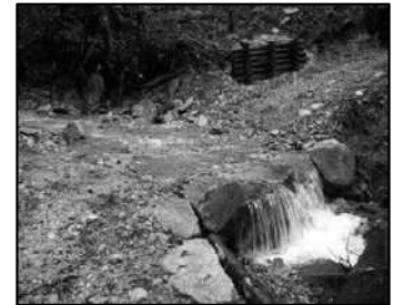
木製橋梁等から荒越工法へ
