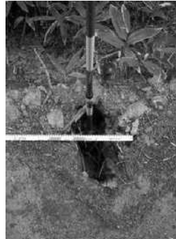
丸太組土留工の水処理
