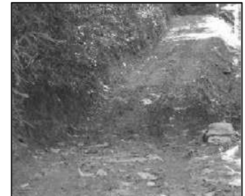
ゴム板等の横断物から波打ち工法へ
