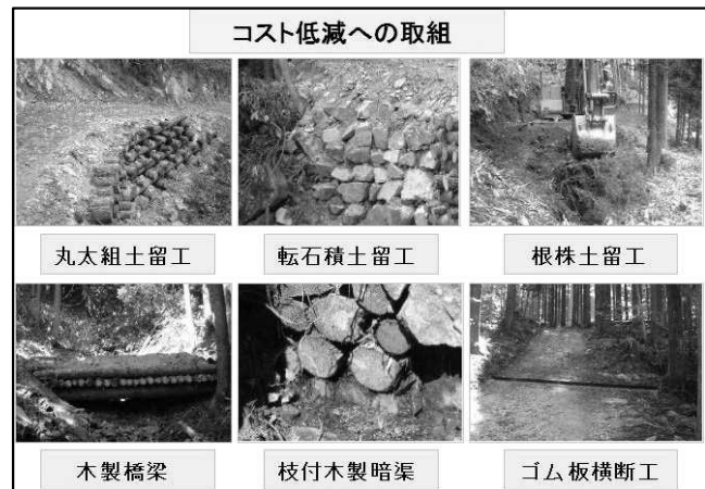
(写真-1) 簡易構造物の施工
