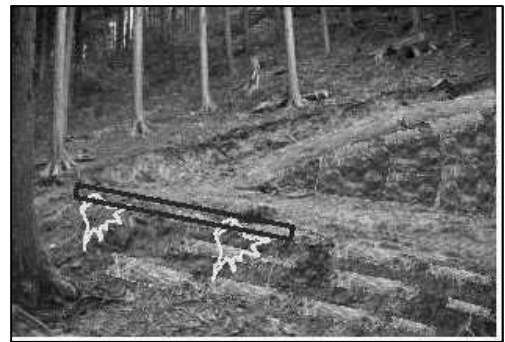
(写真-6) 表土ブロック積み工法(イメージ)
