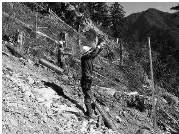
写真22 柵修理中の様子
