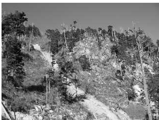
写真21 柵破損状況（崩壊）
