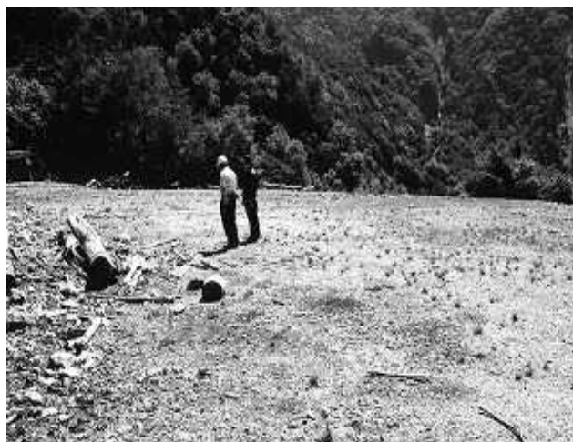
15 シカ柵作設前の状況
