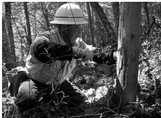
写真23 柵修理中の様子
