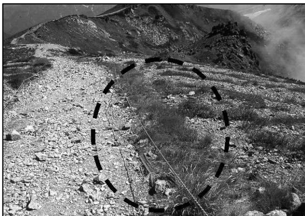
写真2：グリーンネット施工地の復元状況
