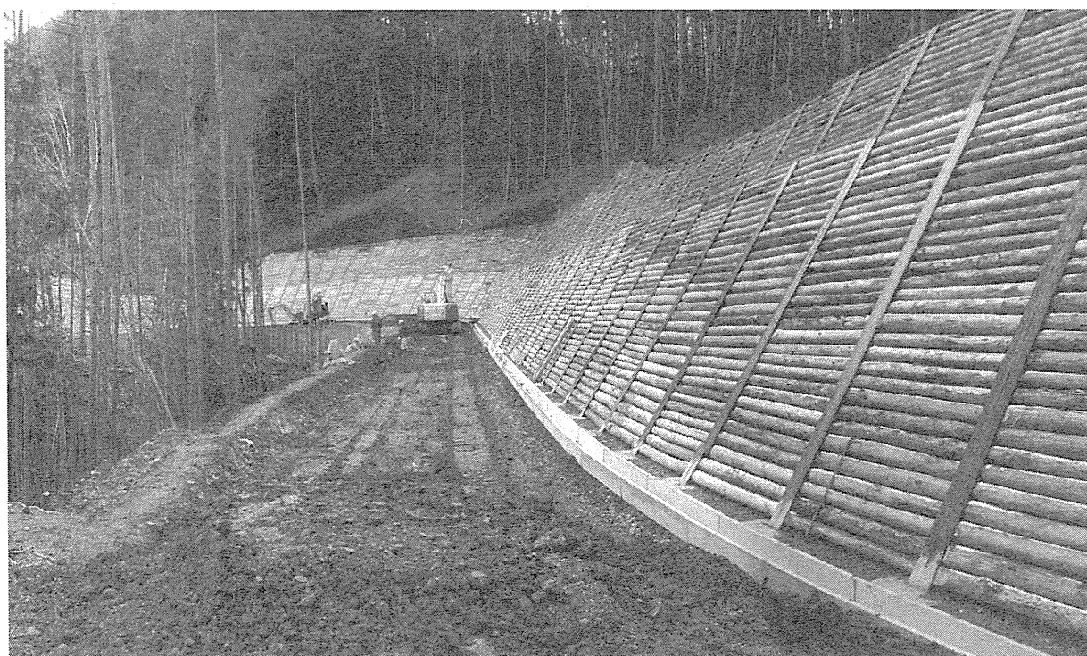
写真7 平成16年度県営林道渡沢鳥居峠線(1工区)開設工事 日義村野上(撮影 H16.12.07)
