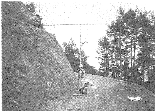
① 切土法面の状況です。
