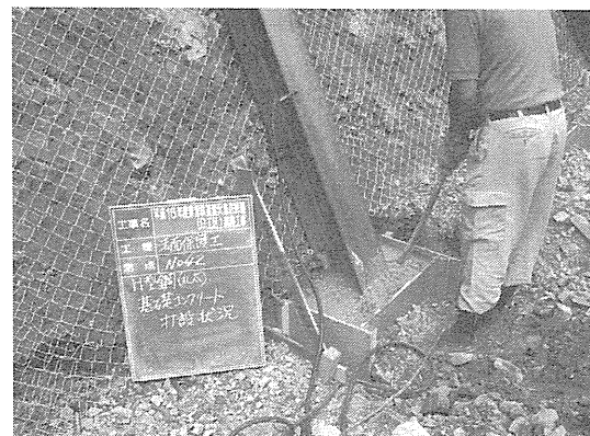
④ 根元はコンクリートで巻き立てます。
