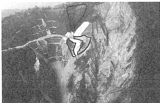
平成16年度施工予定箇所(写真-11)
