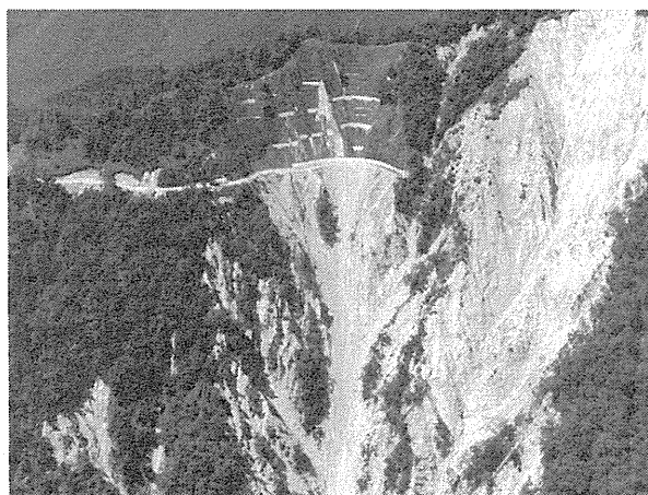
平成13年度崩壊地状況（写真－５）
