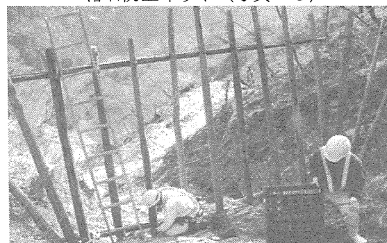
落石防止柵（写真－９）
