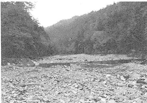
姥ナギ沢谷止工堆砂状況近景（写真-3）
