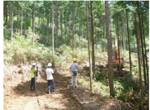
生産性向上モデル事業地での工期調査（愛知所）
