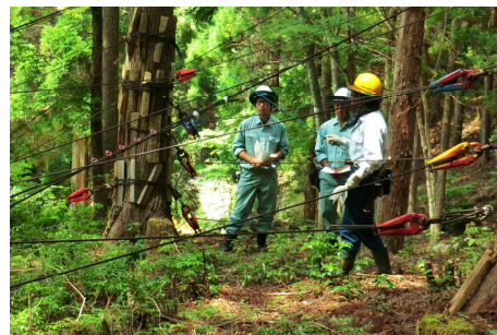
架線集材装置の点検の様子
