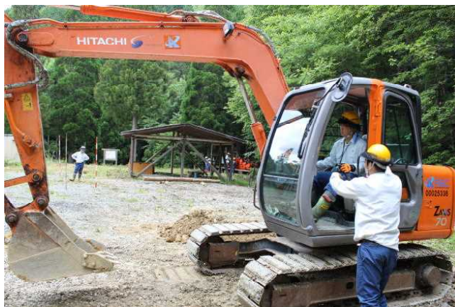
バックホーの運転体験
