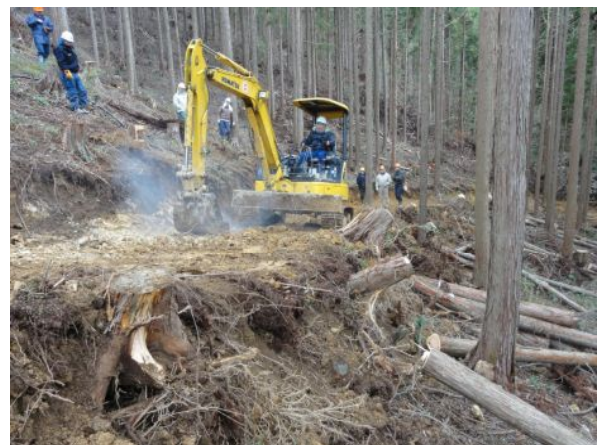
⑫ 岩盤の地山も掘削し均質化して転圧
