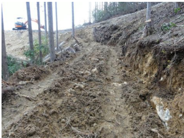
⑬ 仕上げ前の粗道の状況
