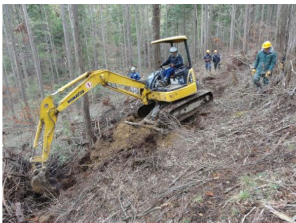
③ 盛土の基礎部作設（水平面を作設）
