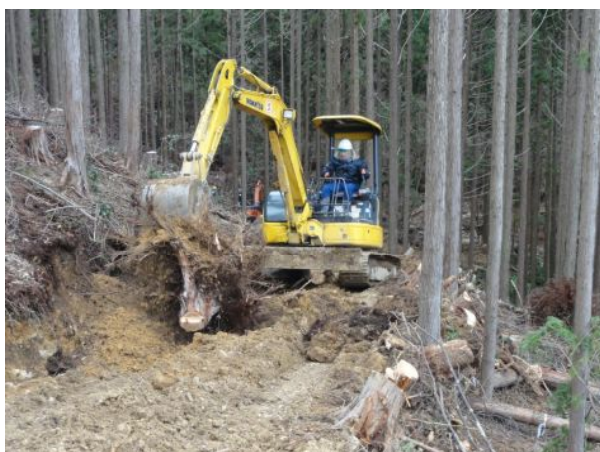
⑤ 根株の掘取り
