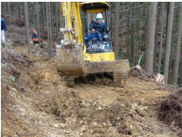
⑨ 盛土は均質化して転圧
