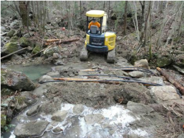
③ 30mm×5mパイプ4本を設置
