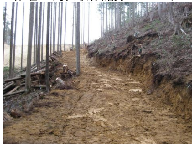
⑱ 仕上げ後の状況(幅員 2.5 ~ 3 m)
