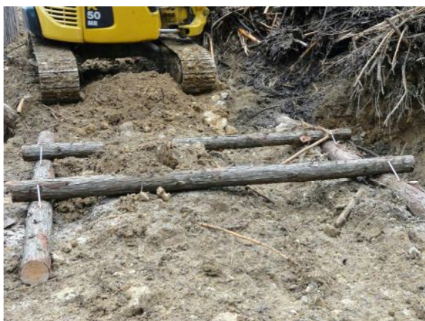
⑤ 丸太土留工の固定にはカスガイを使用
