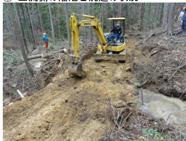
⑥ 上流側の溜池と洗越の状況
