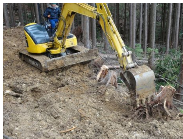
⑥ 根株の据付
