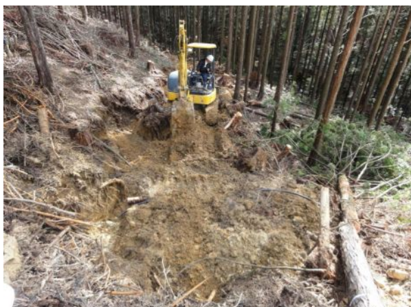
③ 埋設途中の状況
