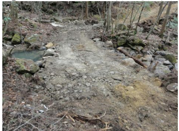
⑥ 30mm×5mパイプ3本追加後の状況
