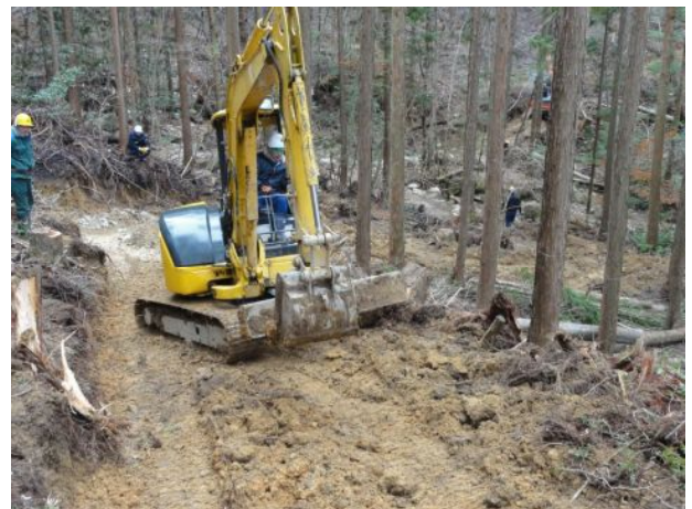
⑩ 履帯による路体の転圧
