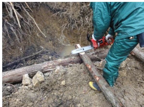
④ 盛土安定のため丸太土留工を設置
