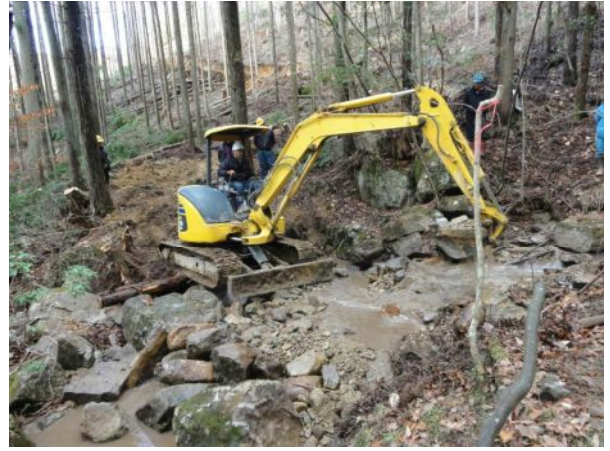
② 洗越の作設の状況
