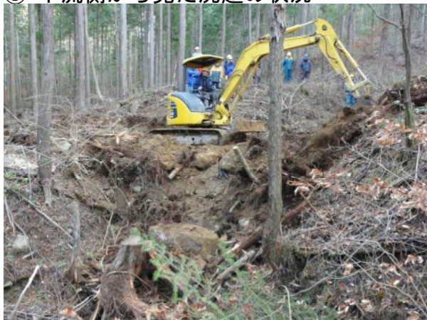
⑤ 下流側から見た洗越の状況
