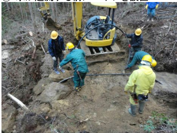
③ 水が越流する前にパイプを設置
