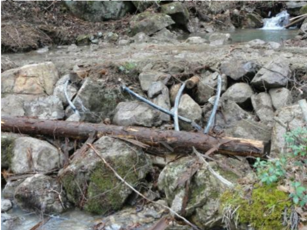
⑤ 下流側から見た洗越作設状況
