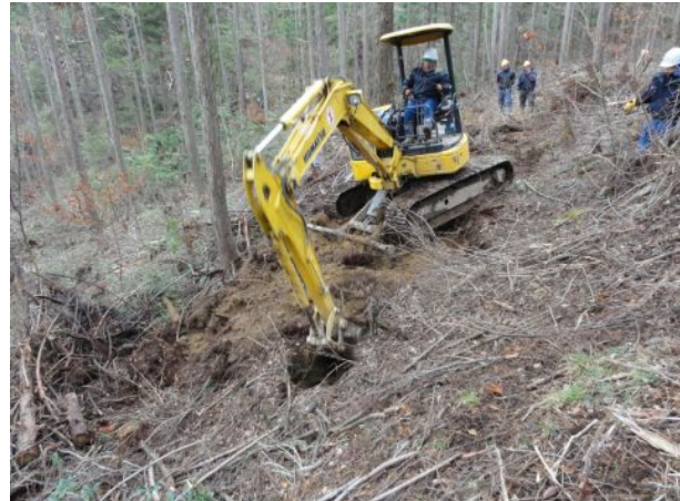
④ 地山も掘り起こし盛土を均質化して転圧
