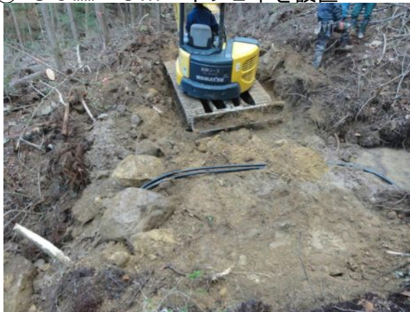
④ 30mm×5mパイプ2本を設置
