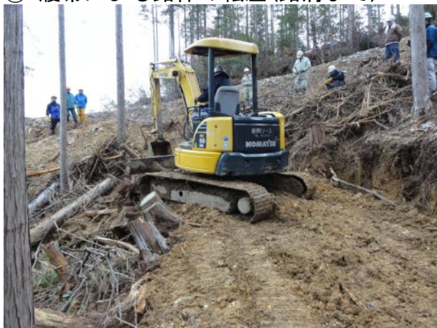
⑰ 履帯による路体の転圧(路肩まで)
