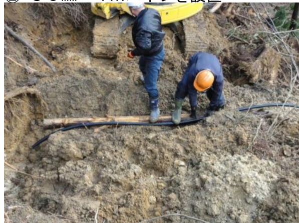
② 30mm×4mパイプを設置
