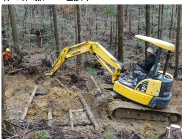
⑤ 丸太敷工の埋設中
