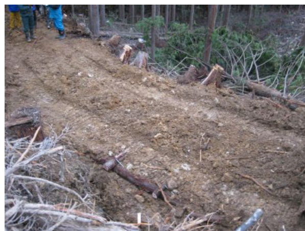
⑥ 丸太土留工設置箇所の粗道の状況
