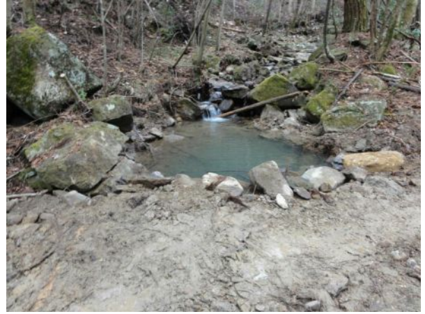
④ 上流側の溜池の状況
