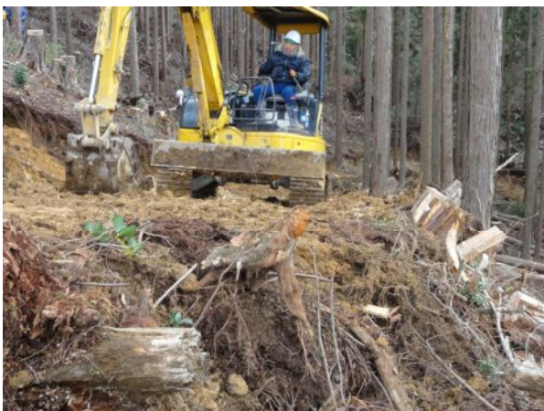
⑪ 表土ブロック積工法及び根株積みの状況
