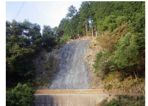
林道の山留に採用した丸太土留工
