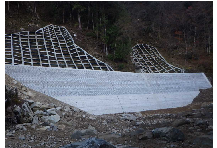
林道災害復旧工事（落合国有林）
