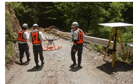
現地での測量作業風景
