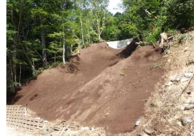
林道整備(災害復旧) (松本市 奈川第一国有林)
