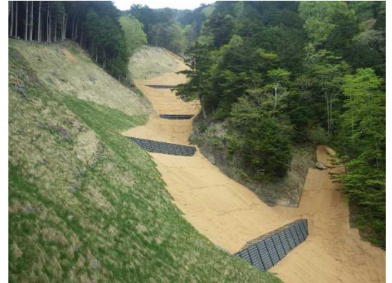
土留工(塩尻市奈良井国有林)
