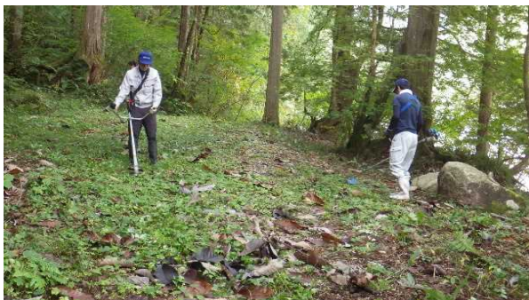
あがりこサワラの森へ向かう歩道整備の様子
