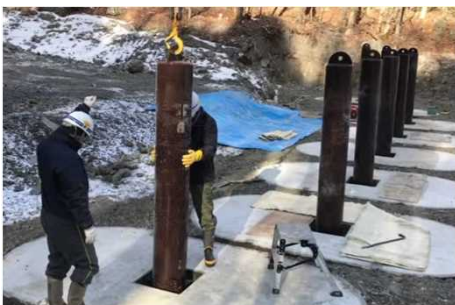
流木を捕捉するスリットの据付け 独立基礎型流木捕捉工(塩尻市奈良井国有林)
