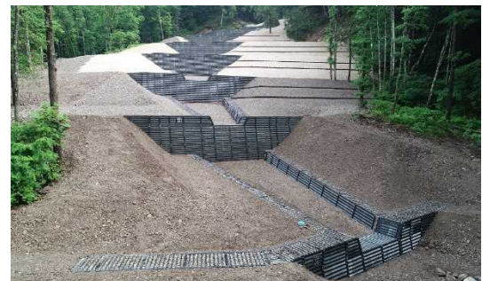
鋼製樁谷止工(大町市籠川谷国有林)
