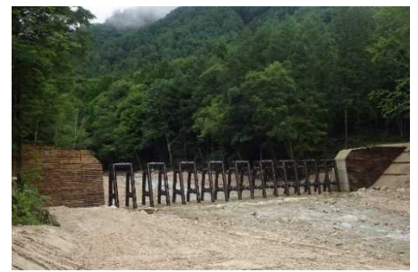
鋼製スリット床固工 (松川村馬羅尾国有林)
