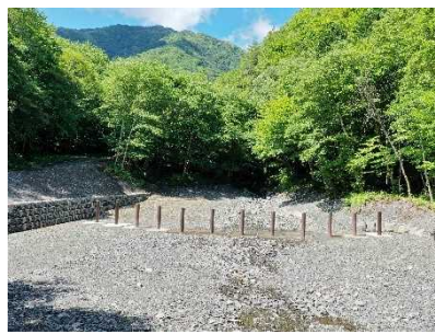
流木を捕捉するスリットの据付け 独立基礎型流木捕捉工(塩尻市奈良井国有林)
