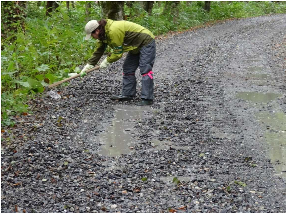
9月17日 治山運搬道の水切り作業
