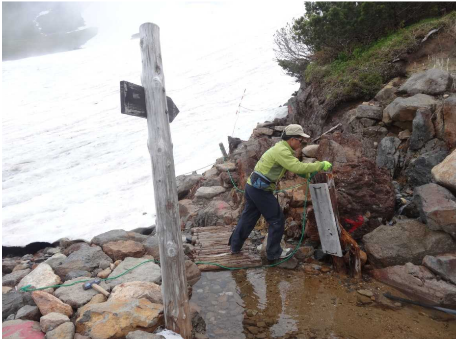
足元が悪い場所にもグリーンロープを張ります。
