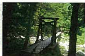
恋路のつり橋 柿其川にかかる長さ約35mの吊り橋です。
