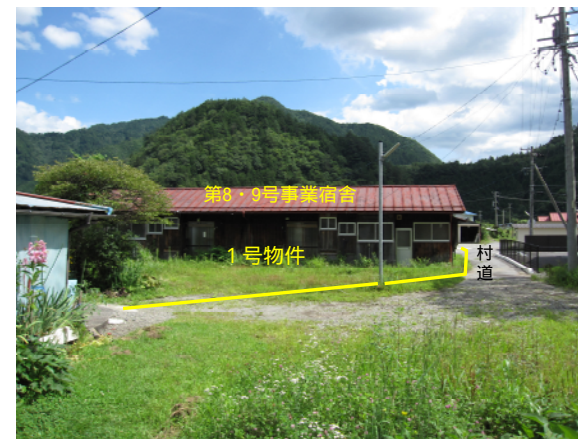
物件北側から撮影
