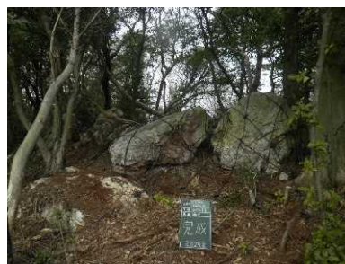
ロープネット工による落石対策
