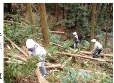
▲間伐と遊歩道づくりによる土留め
