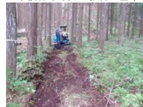
▲作業道造り作業中
