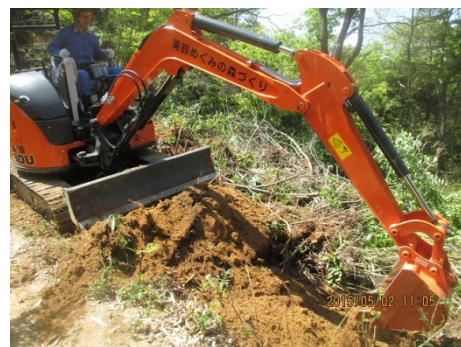
▲作業道と遊歩道を一体的に整備
