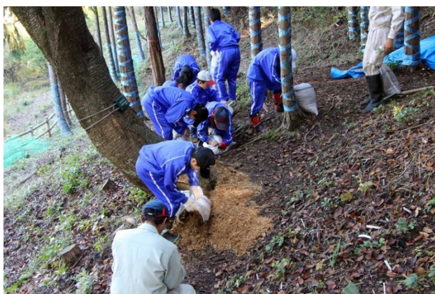
▲樹木に悪影響を及ぼさないように、道に露出した樹根を保護する木質チップ敷設作業
