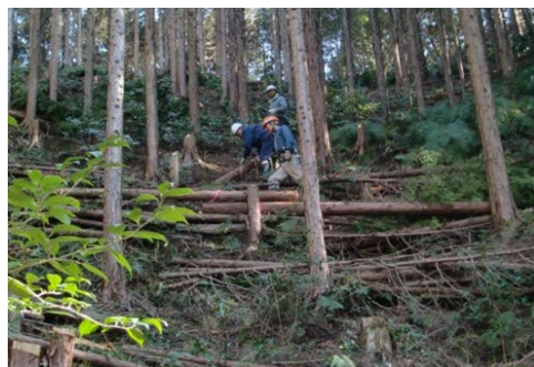
▲森林内での土留め整備
