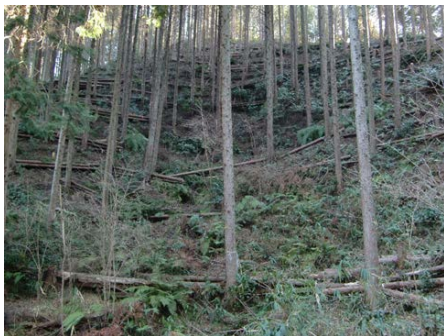
▲間伐材活用の土留め
