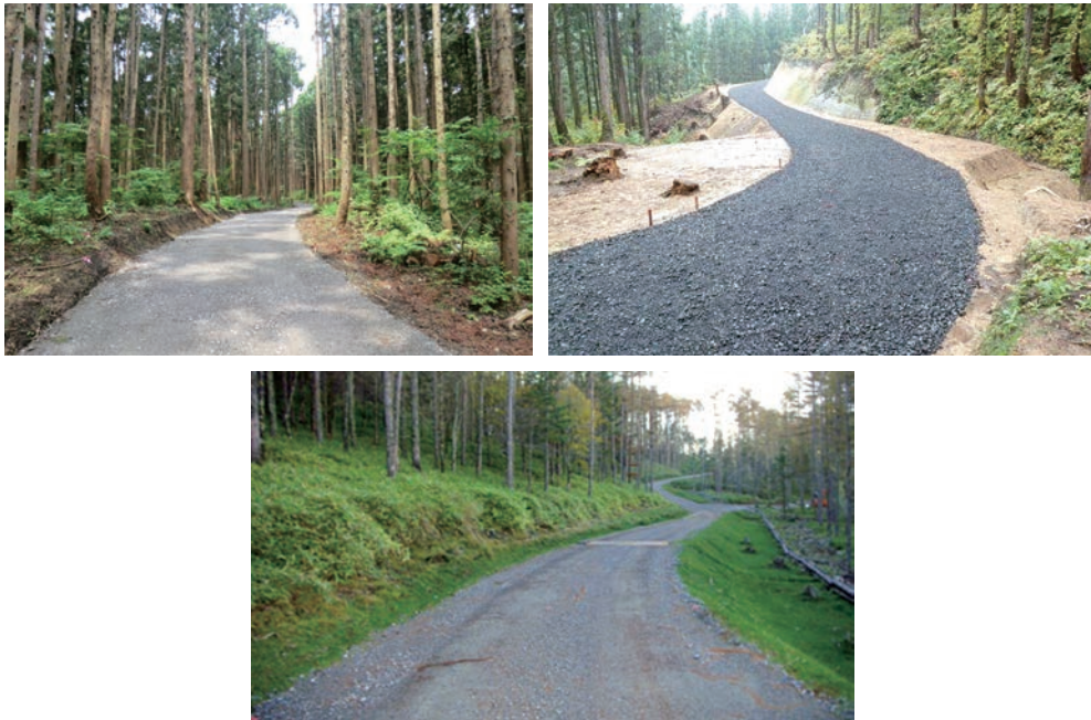
写真6-2 林業専用道(のり面は低く抑えられ、土工量が小さく、林内へのアクセスが容易)
