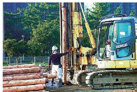
写真8-10 丸太打設による軟弱地盤改良
