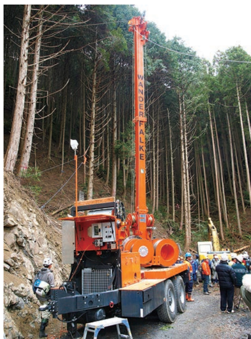
写真6-5 先進的な架線系林業機械の例
