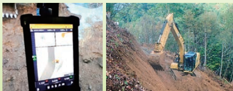
ICT建機における モニター画面
