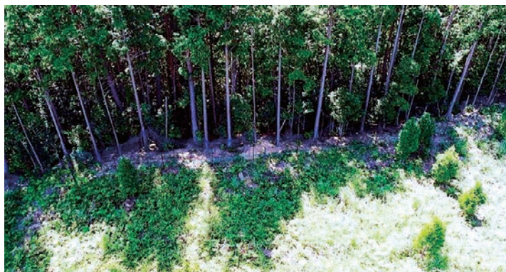
写真2-17 ドローンによる防護柵の点検
