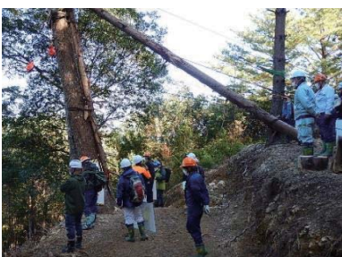
ダブルエンドレス方式集材架線の先柱での説明:2日目
